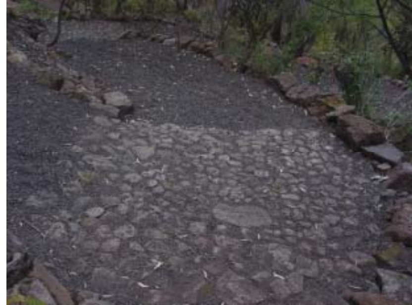
Foto 15. Mismo acceso terminado con recubrimiento de tezontle, guarniciones de roca y descansos de empedrado en dos curvas que además estabiliza el recubrimiento de tezontle.
