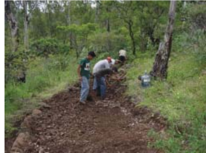
Foto 11. Trabajos de desplante y nivelación del terreno.
