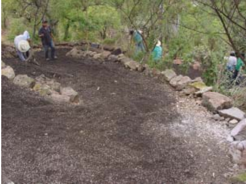
Foto 14. Acceso norte con terreno desplantado y apisonado con guarniciones de roca acomodada, durante la aplicación del recubrimiento de tezontle.
