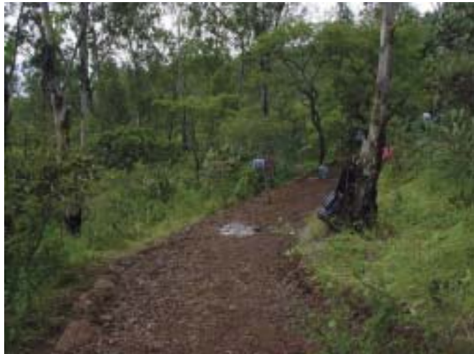
Foto 12. Misma sección ya desplantada y suelo apisonado con guarnición de roca acomodada.
