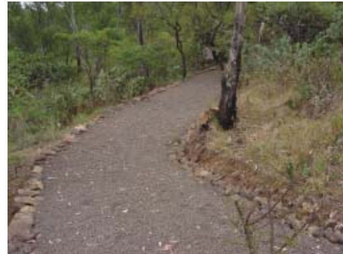
Foto 13. Sección de andador terminada con recubrimiento de tezontle negro y guarniciones de roca acomodada.
